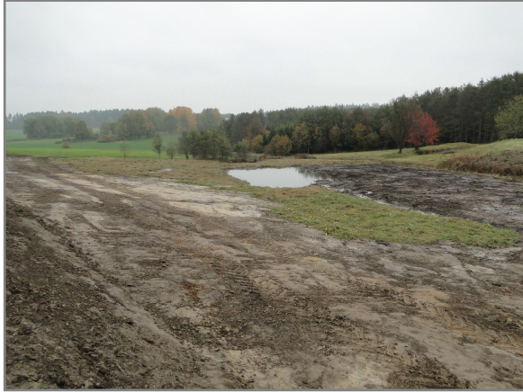
Abb. 3: 3xB-Fläche Gschöd, Renaturierung und Biotopgestaltung durch Freilegen des Torfkörpers und Abdecken mit Mähgut
