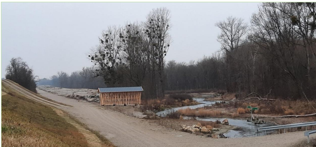
Umgehungsgerinne am Kraftwerk Ering-Frauenstein mit neuer Naturbeobachtungsstation
